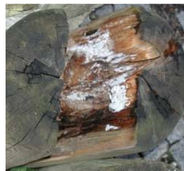
Abbildung 42 Schadbild und kleine Fruchtkörper (Quelle: www.holzfragen.de )
