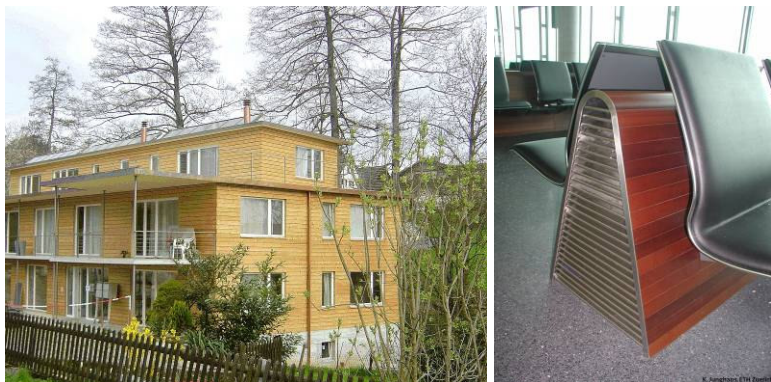
Abbildung 77 Einsatzbeispiele für thermisch vergütetes Holz in der Schweiz (Mehrfamilienhaus, AG. Sitzreihen im Flughafen Zürich-Kloten)
