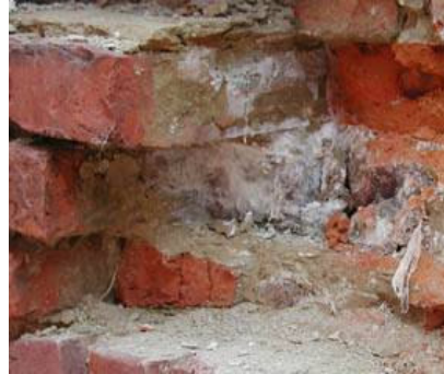
Abbildung 46 Vom E.H. durchwachsendes Mauerwerk (Quelle: www.holzfragen.de )
