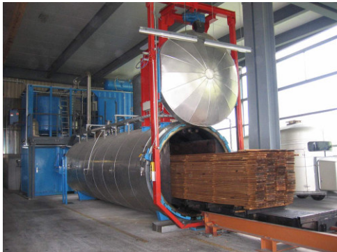
Abbildung 76 Thermoholz-Anlage der Fa. Balz Holz in Langnau i.E.
