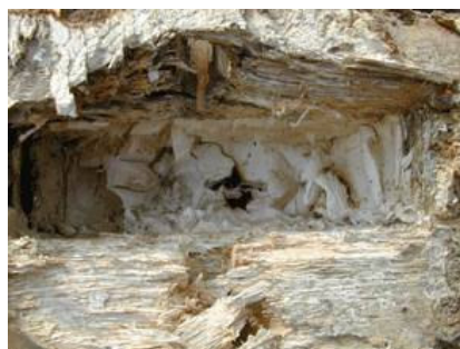
Abbildung 51 Fruchtkörper des Eichenporlings Abbildung 52 Myzel im Riegelanschluss eines Fachwerkbaus (Quelle: www.holzfragen.de ) (Quelle: www.holzfragen.de )
