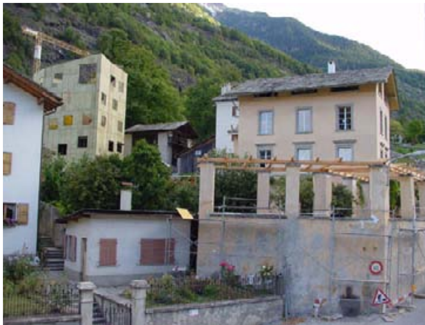
Konferenz- und Begegnungsort (Villa Garbald) in Castasegna, Kanton Graubünden. Alt- und Neubau wurden mit digital vernetzten Technologien ausgestattet. Konzeption und Koordinierung durch die Professur für CAAD, ETH Zürich.
