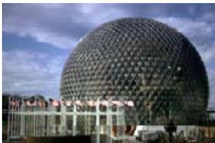
Pavillon der USA an der Weltausstellung 1967 in Montreal, Kanada. Geplant war, dass die Storen in den Dreiecken der Strukturen über einen Computer vernetzt ansteuerbar sind, und damit auf Sonnenschein, Einfallswinkel und innere Nutzung reagieren können.
