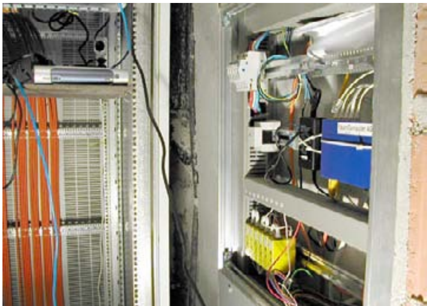
Konferenz- und Begegnungsort (Villa Garbald). Die zentrale Steuerung mit den per Software integrierten Diensten.
