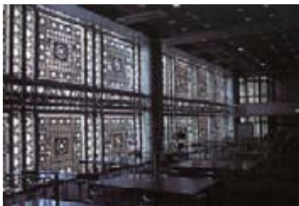
Feinteiliger individuell Verstellbarer Sonnenschutz der Fassade des Institute du Monde Arabe, Paris. Die vernetzt Steuerung der Irisblenden erlaubt die Bedienung der grossen Menge an individuell konfigurierbaren Bauteile.
