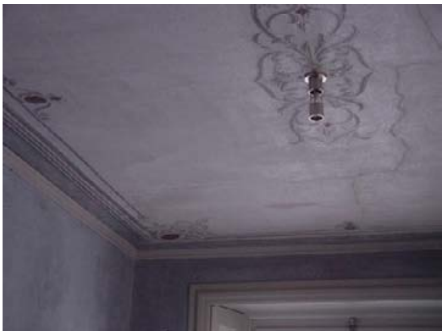
Digital gesteuerte Leuchte im Semperschen Altbau der «Villa Garbald».
