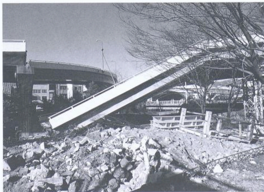
Bild 11. Absturz des Trägers einer Verbundbrücke
