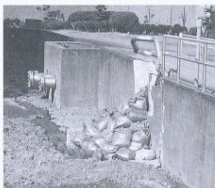
Bild 7. Behelfsmässig mit Sandsäcken abgedichteter Riss im Auffangbecken eines Tanklagers
