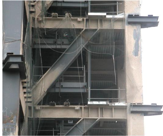
Bild 5.11: Hochhaus mit einem exzentrischen Fachwerk zur Abtragung der horizontalen Erdbebenkräfte
