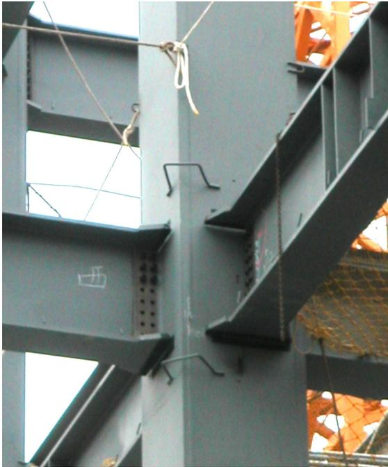
Bild 5.6 : Riegelanschluss in einem duktilen Stahlrahmen eines Hochhaus in Taipeh. Dank der Flanschverbreiterung stellt sich das plastische Gelenk im wesentlich duktileren Riegelprofil vor der spröderen Schweissnaht ein.
