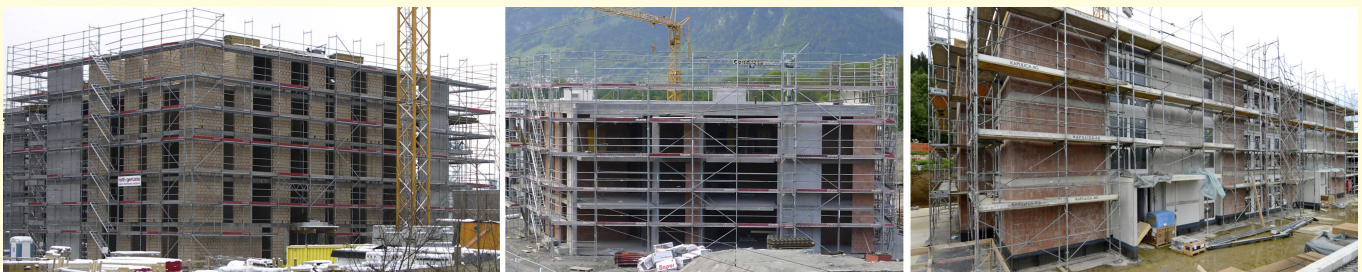
Bild 3. Baustellen von Wohnungsbauten mit Mauerwerks- und Stahlbetontragwänden in Erdbebenzone Z1 (links), in Erdbebenzone Z2 (Mitte) und in Erdbebenzone Z3a (rechts).
