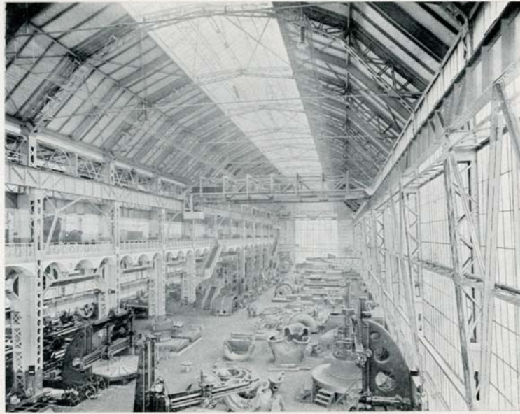
Maschinenhalle (Arch. Peter Behrens) Berlin
