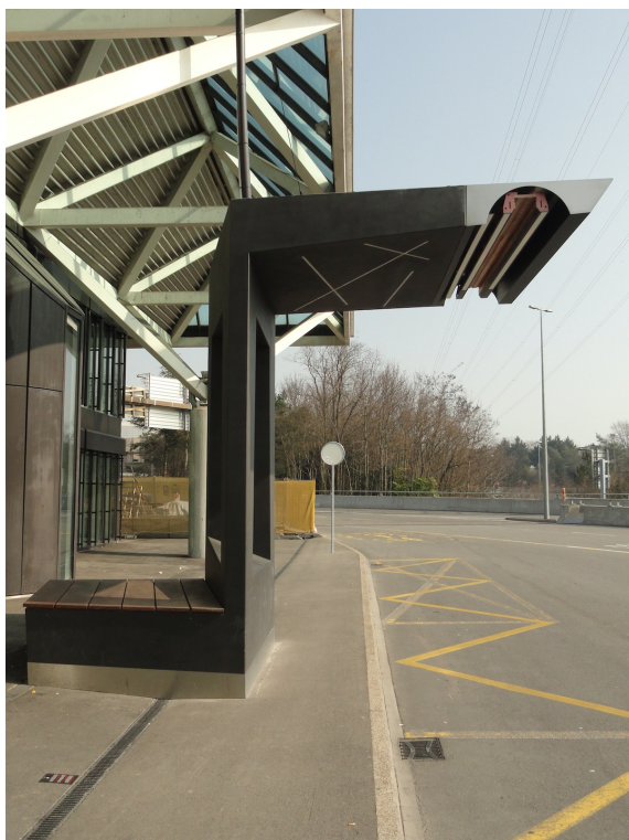
Abbildung 3.4: Beispiel einer Ladestation für konduktive Zwischenaufladung (Genf Flughafen, 14.03.2014)
