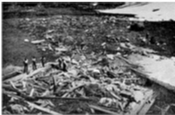
Fig. 16: Die zerstörte Alphütte auf Alp Galtenebnet im Bisistal. (Photo Oechslin)
