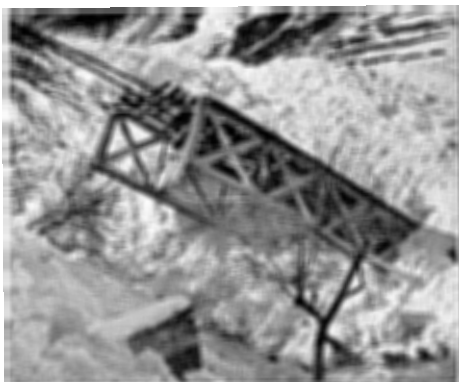
Fig. 25: Lawinen im Zermattetal. Durch die Embdbachlawine am 12. Febr. 1945 weggetragene 30-Tonnen-Eisenbahnbrücke hinter der Station Kalpetran.
