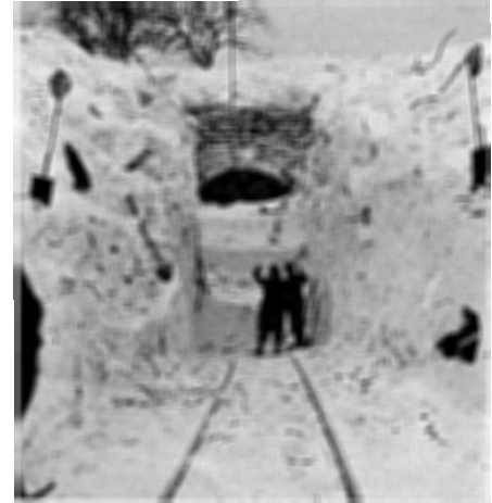
Fig. 24 Lawinen am Brienersee. Verschüttetes Tunnelportal bei der Station Oberried (Lauigrabenlawine). (Photo Maeder)
