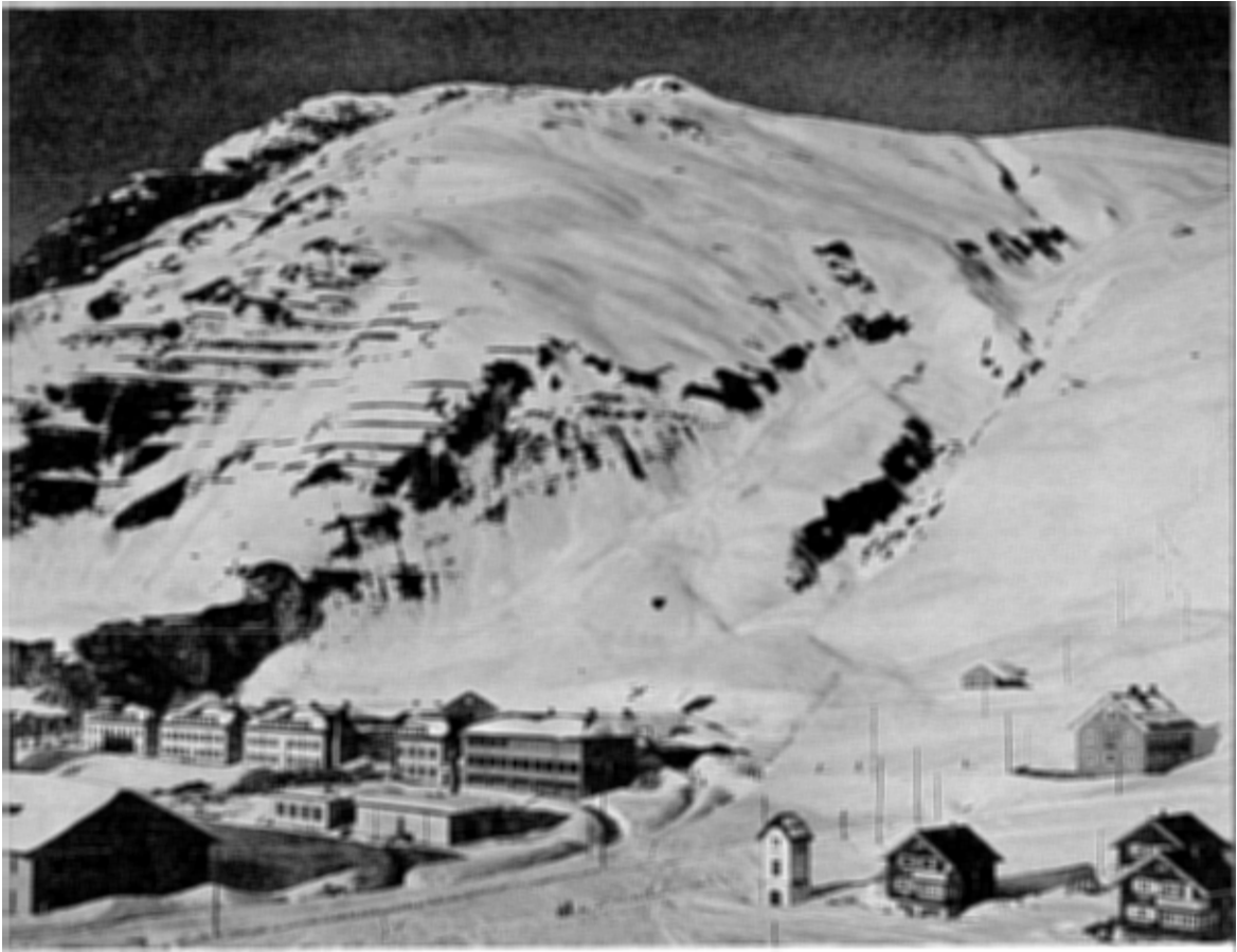
Fig. 26: Lawinunglück bei Andermatt, 8. März 1945. Der Anbruch erfolgte in den ungenügenden Verbauungen am Kirchberg. Nach dem Abgleiten über den Südhang des Kirchberges teilten sich die Schneemassen im Graben des Dürstelenbaches in zwei Arme. Während der links auf dem Bilde abfließende Teil der Lawine vor Erreichen der Gebäude zum Stillstand kam, zerstörten die im Hauptgraben niederstürzenden Schneemassen, gemeinsam mit dem entwickelten großen Luftdruck, die Stallungen und ein Kasernengebäude. (Photo Haemisegger)
