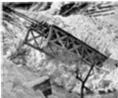
Fig. 25: Lawinen im Zermattetal. Durch die Embdbachlawine am 12. Febr. 1945 weggetragene 30-Tonnen-Eisenbahnbrücke hinter der Station Kalpetran.
