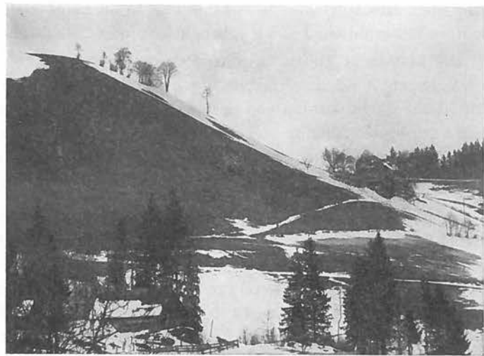
a) Ansicht des Lawinenhanges aus Süden. Im Mittelgrund rechts das beschädigte Gebäude
