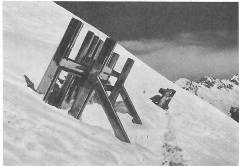
Fig. 34 Aluminiemelemente (Aluminiumwerke Rorschach). Werke 7 west und ost, links Rechen, rechts Brücke. (Photo R. Figilister).
