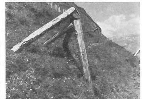
m) Vierbeinbock aus Holz, 1 Werk pro Feld, „Rudolf“ Feld Nr. 78 (analog „Fopp“ Nr. 7, jedoch Dreibeinbock).
