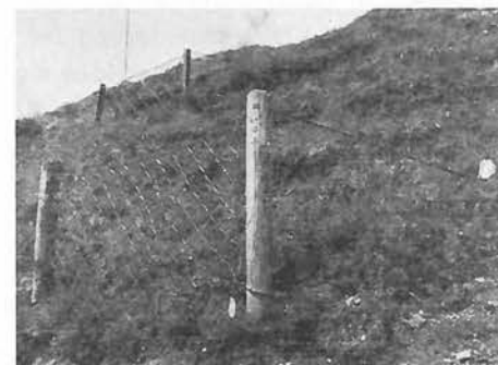
l) Drahtgitterwerk (unten) und Kabelnetzwerk (oben), 2 Werke pro Feld, „Rudolf“ Feld Nr. 67 (analog „Fopp“ Nr. 99).
