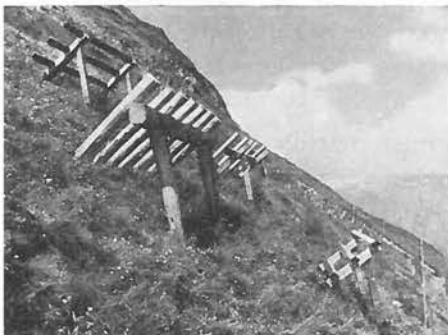
k) Schneerechen und Schneebrücken aus Holz und Aluminium, 4 Werke pro Feld, „Rudolf“ Feld Nr. 17 (analog „Fopp“ Nr. 33).
