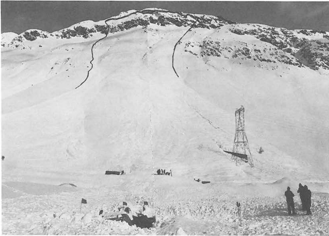
Figur 35c Ansicht der Unglückslawine mit Anriß, Sturzbahn, Straßenverlauf und Verschüttungsstelle des Unfallwagens
