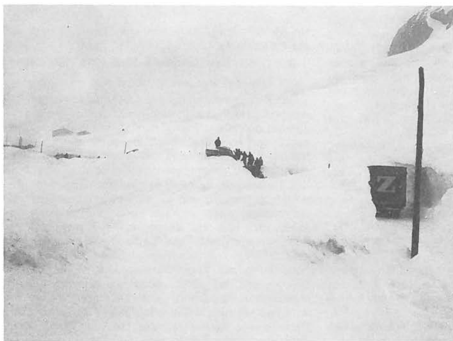
Figur 37b Die Unglücksstelle während den Rettungsarbeiten. Im Hintergrund die Gebäude von Chant Sura
