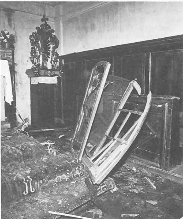
Figur 23b Schäden im Innern der Kirche von Arvigo (Fotos: Kantonspolizei GR)
