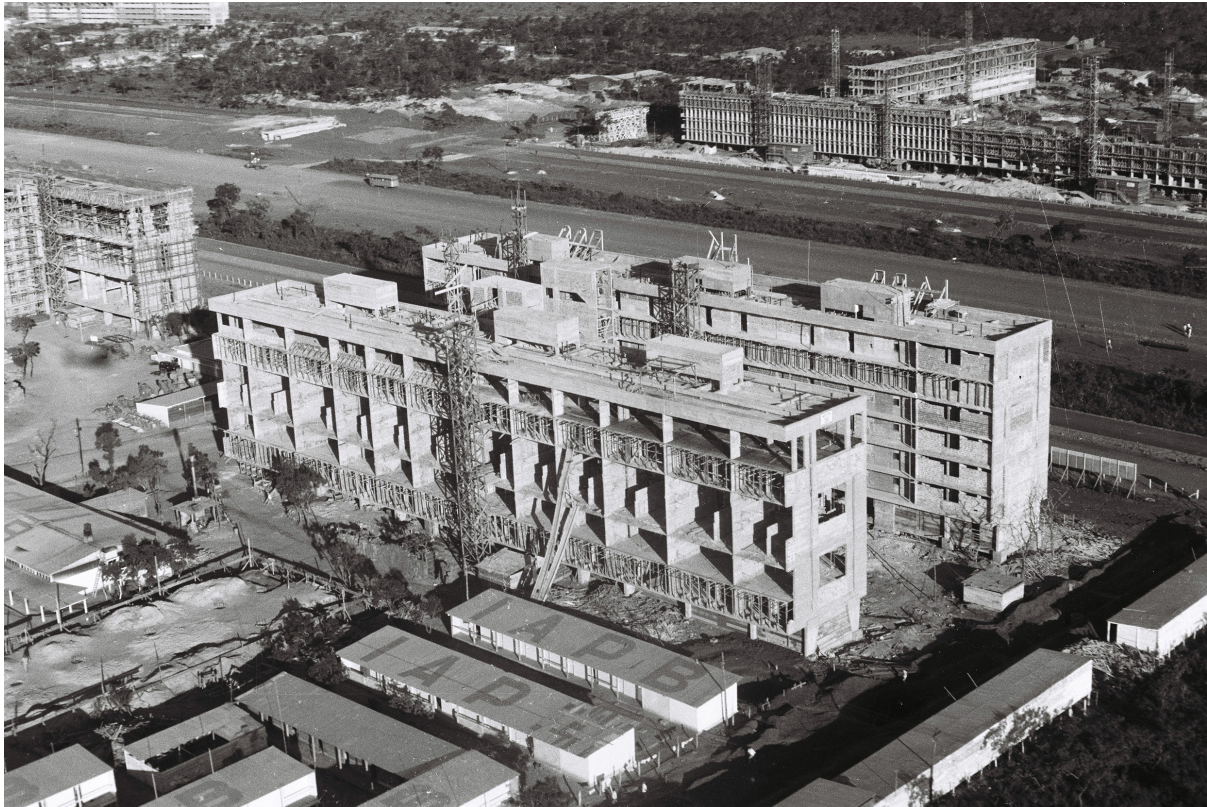
Fig. 1.10 Superquadra 108 South (SQS 108) under construction. Brasília, 1959. Photograph by Mario Fontenelle, Arquivo Público do Distrito Federal, Brasília
