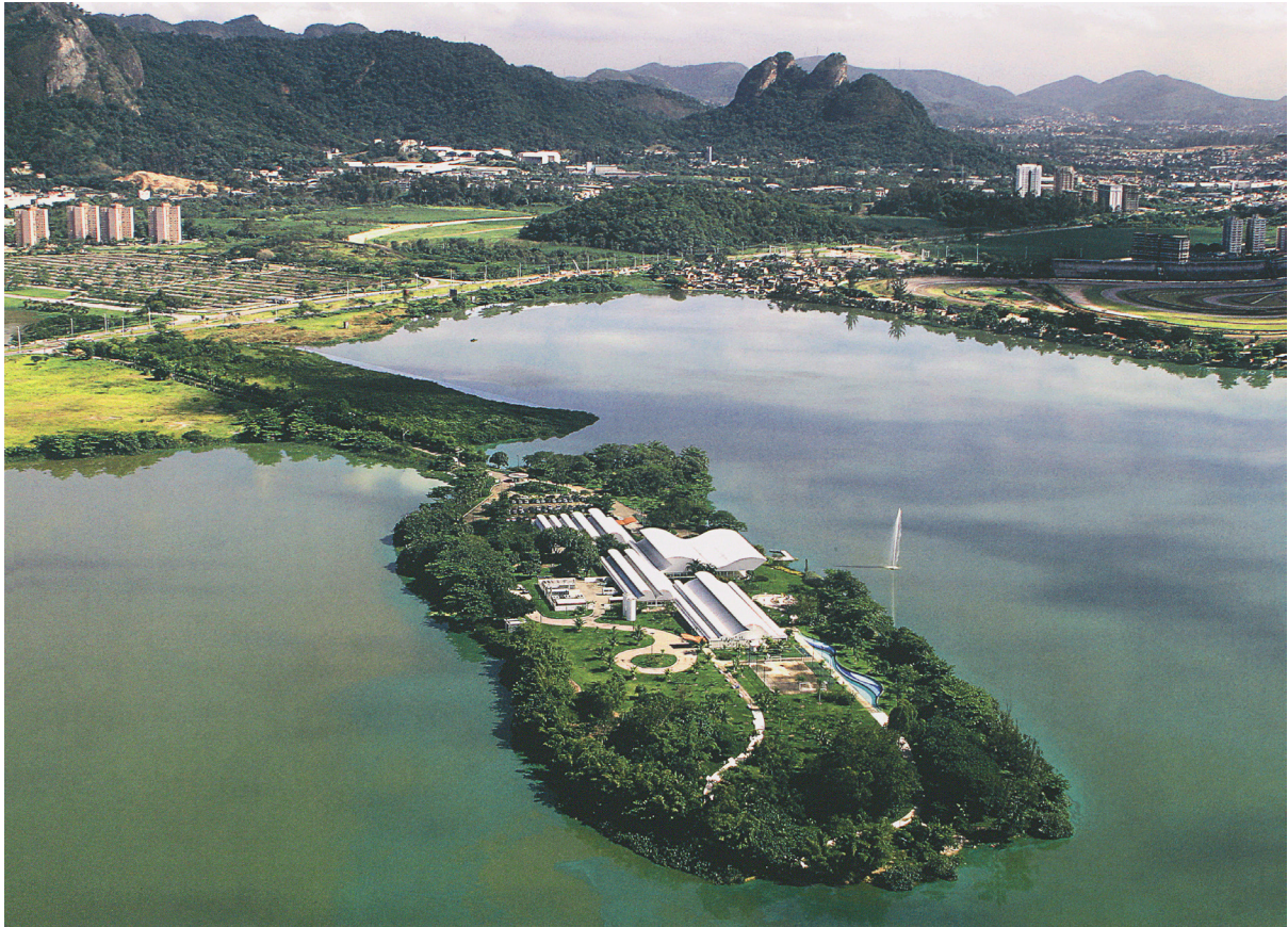
Fig. 1.34 Children's Rehabilitation Center (Sarah hospital) at Pombeba Island. João Filgueiras Lima, Rio de Janeiro, 2001. M. Risselada and G. Latorraca, A arquitetura de Lelé: fábrica e invenção (São Paulo: Imprensa Oficial de SP/MCB, 2010), p. 152
