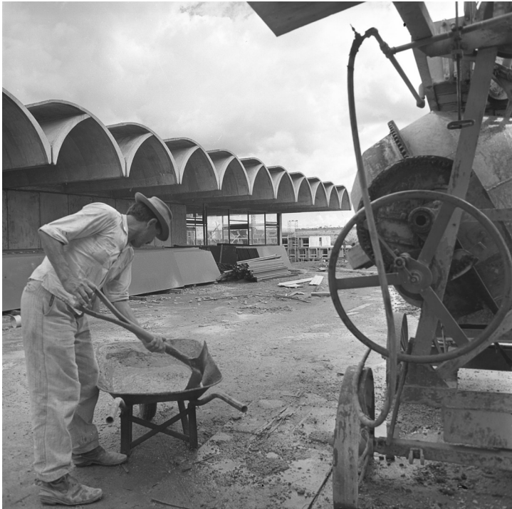
Fig. 1.53 Taguatinga Hospital under construction, 1972. João Filgueiras Lima, 1968. Arquivo Público do Distrito Federal, Brasília
