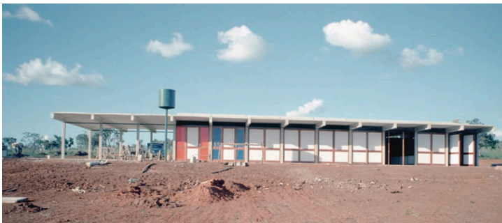
Fig. 2.54 Precast argamassa armada school for 70 students. Lelé, Abadiânia, 1984. Marina Mange Grinover, “Laboratório de projeto e construção: prática da arquitetura na obra de Renzo Piano e João Filgueiras Lima”, PhD diss., (Universidade de São Paulo, 2015), 364
