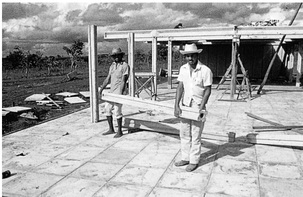
Fig. 2.33 Manual handling. Hollowed precast column. Abadiânia (1984). João F. Lima, Arquitetura: uma experiência na área de saúde (São Paulo: Romano Guerra, 2012), p. 59
