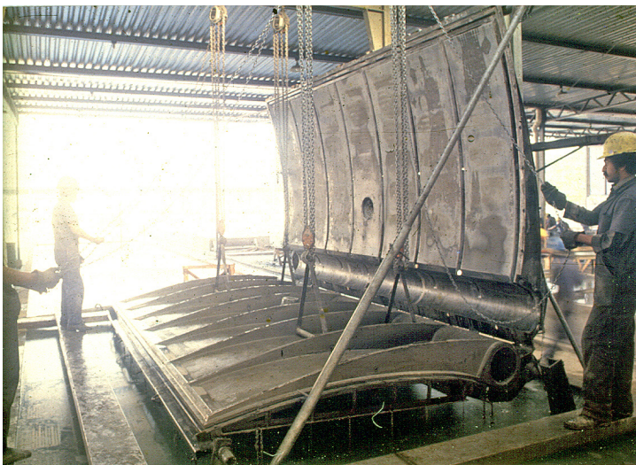
Fig. 2.26 Metallic mold for the argamassa armada bus shelter. Design by Mariano Casañas. Rio de Janeiro, 1985. Arquivo João Filgueiras Lima, Salvador
