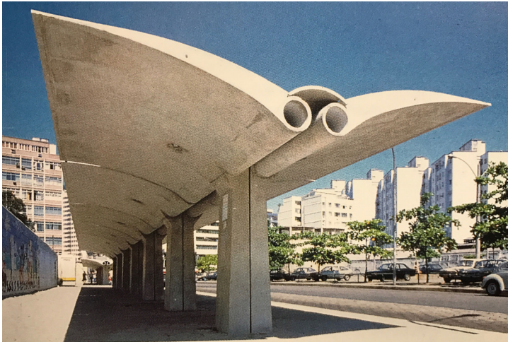
Fig. 2.25 Bus shelters in argamassa armada. Lelé, Rio de Janeiro, 1985. Photograph by Celso Brandó. Arquivo João Filgueiras Lima, Salvador
