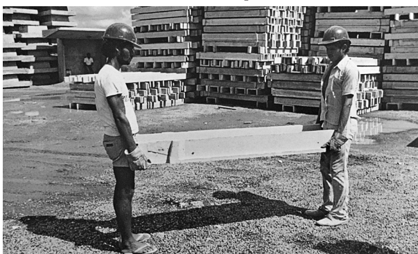
Fig. 2.35 Manual handling. Channel's wall element. RENURB, Salvador (1980). João Filgueiras Lima, Escola Transitória Modelo Rural (Brasília: MEC/CÉDATE, 1984), p. 13
