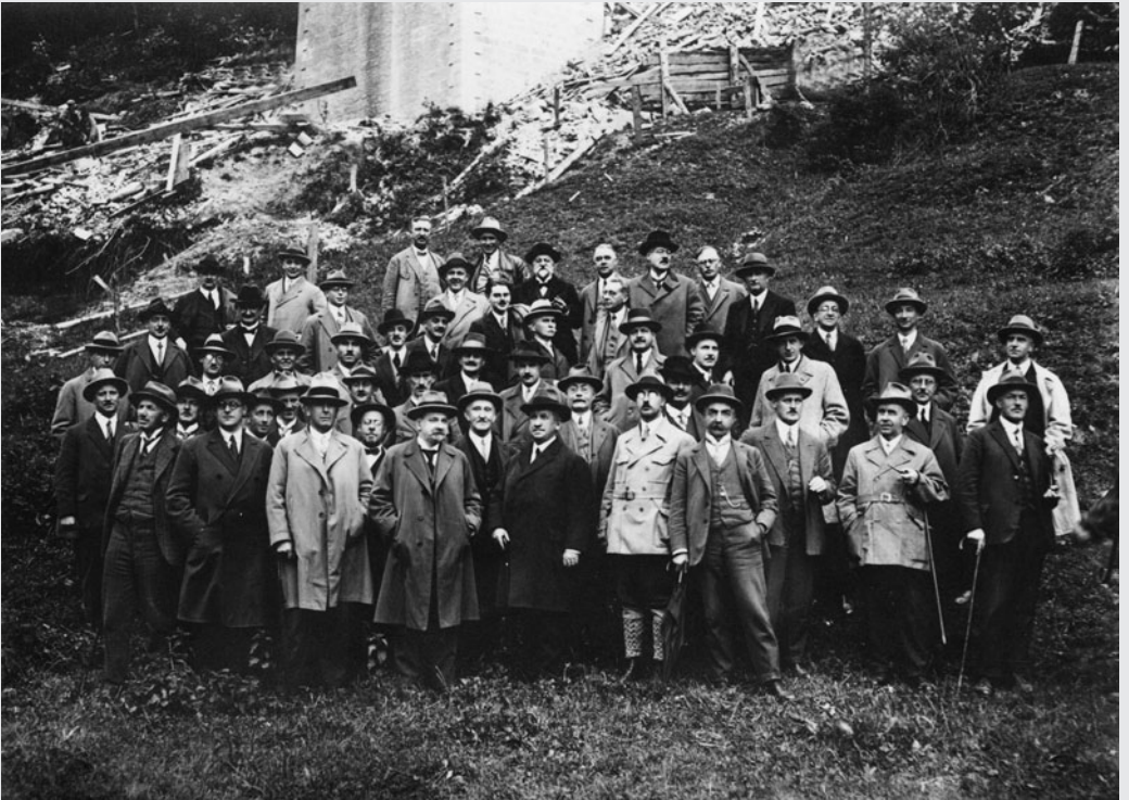
Unbeschriftetes Bild aus dem Aktenpaket 1925. Mit Bezug auf das Gelände und das Fundament (Brückenpfeiler) könnte es sich um die Exkursion vom 24. Mai 1930 zur Baustelle Viadukt St.Ursanne handeln.
