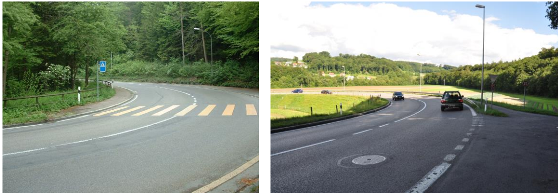
Abbildung 7-7: Strassenbeleuchtung in Kurven
